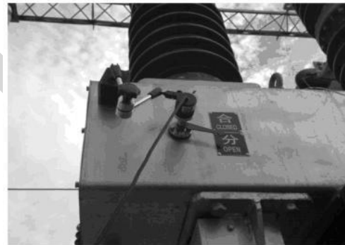
35KV SF6 开关传感器安装
